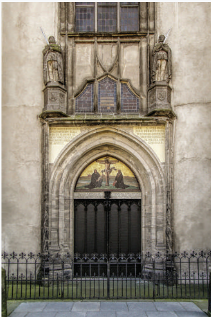
Porte de la chapelle du château de Wittenberg, lieu où furent affichées les 95 Thèses, en 1517.
